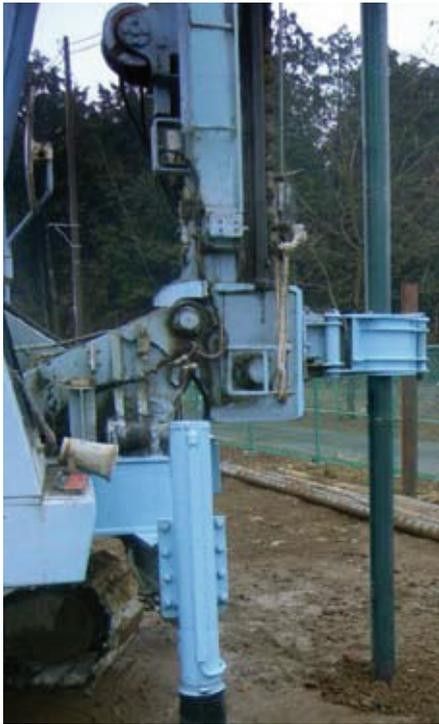
支持地盤の確認と打ち止め管理は、調査データより、各パターンを想定し、貫入速度および回転トルク値を計測することにより、確実に設計支持力が期待できるように管理しています。また、非常に堅固な地盤に貫入する場合、長時間にわたる回転貫入は支持地盤を乱し、支持力が低下する場合がありますことを実験により証明し、打ち止め管理方法を定めています。
